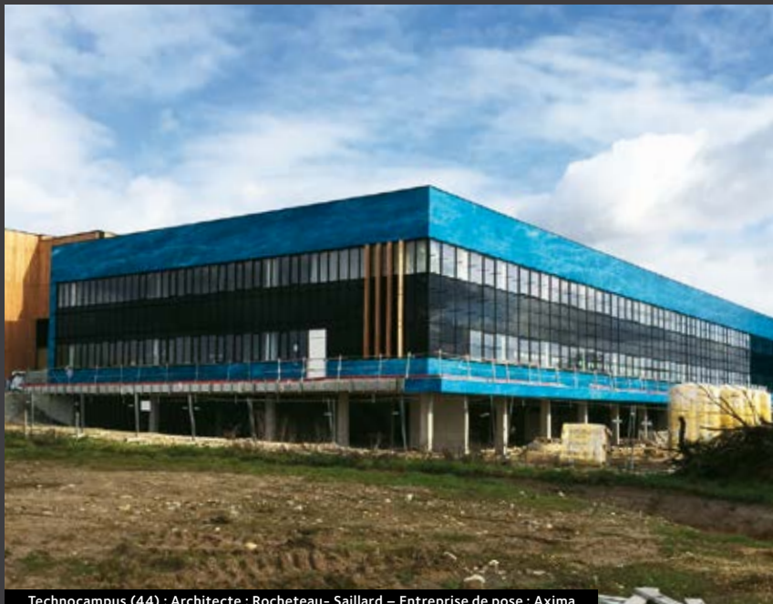
Technocampus (44) : Architecte : Rocheteau - Saillard – Entreprise de pose : Axima
