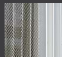
Apport Arval by ArcelorMittal Enveloppe en profil trapeza 7.96.54 avec recouvrement transversal, en pose verticale
