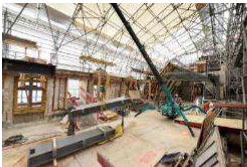
Travail de renfort en sous-œuvre dans des mansardes exigües (Photo : Michael Tubiana)
