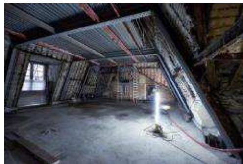
Nouvelle structure métallique greffée sur les profils existants (Photo : Michael Tubiana)
