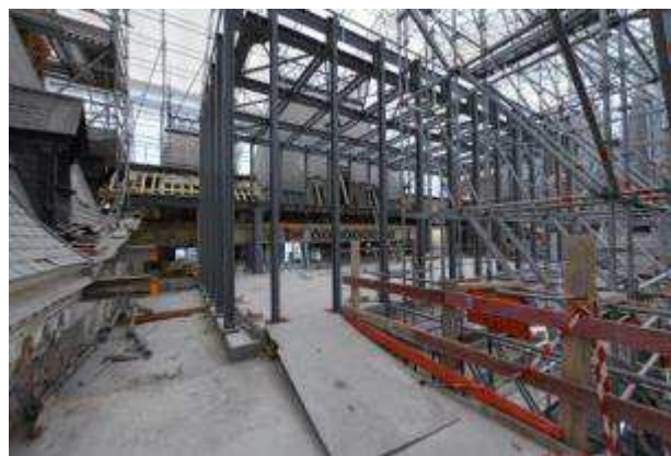
Création d'une extension en structure métallique dans le prolongement de l'ancienne toiture (Photo : Michael Tubiana)
