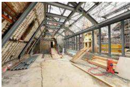
Opération de renfort par addition d'une nouvelle charpente métallique (Photo : Michael Tubiana)
