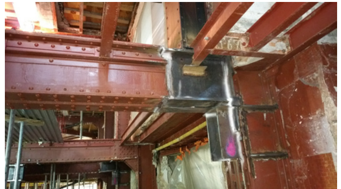
Chevalement métallique pour reprendre les charges correspondantes aux 9 niveaux de plancher.
