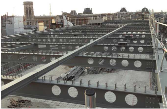
Ouverture dans les poutres pour le passage de gaines.
