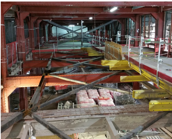
Mise en place de palées provisoires sur la périphérie pour assurer la stabilité avant la démolition du cœur de plateau.
