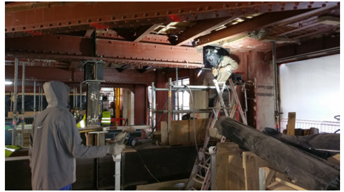
Découpe de la poutre au droit de l'attache existante.
