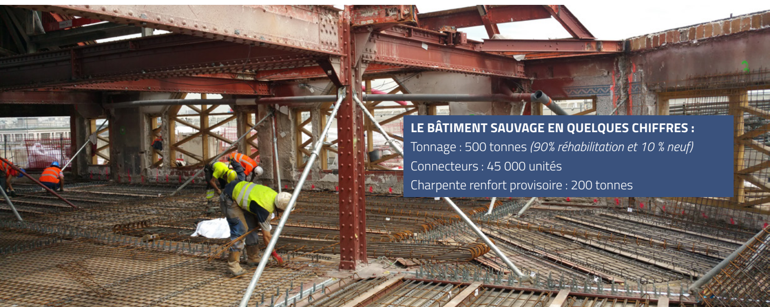
Mise en oeuvre de connecteurs sur les poutres de plancher PH8.
