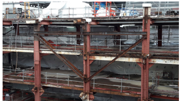
Reprise des charges du poteau central afin de permettre la suppression de l'appui en partie basse.
