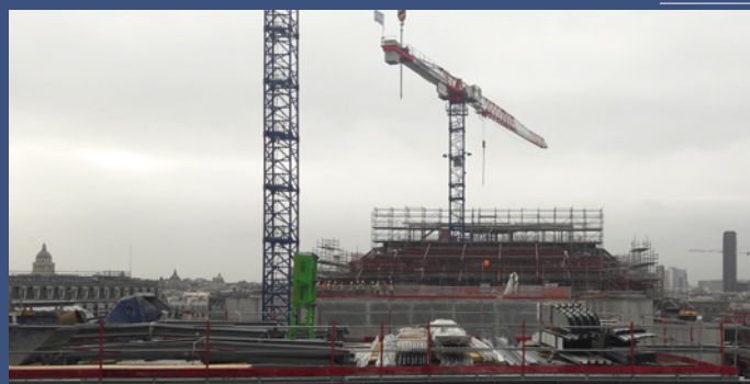
Grue à tour.
