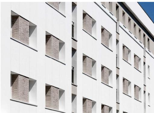
*Exemple de mixité enduit / brique sur bardage*
