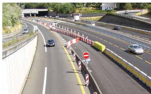
Balisage, protection et signalisation d'itinéraires de déviations (la rocade Ouest A630 de Bordeaux).
