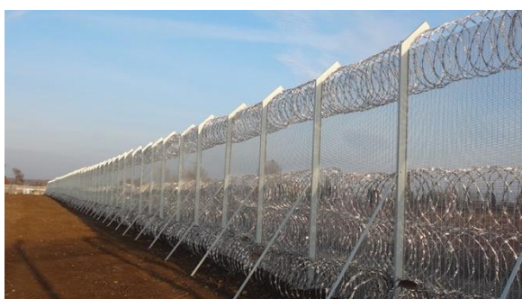
Mise en place de clôtures et filets périmétriques des maisons d'Arrêt d'Albi, Seysses et Uzerche.
