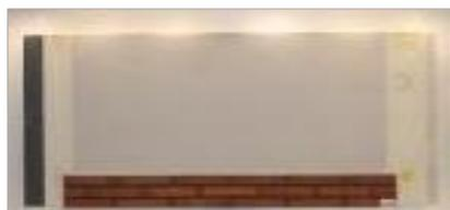
Esthétique mixte sur système d'ITE hydraulique : brique collée en partie basse (StoTherm Brick) et enduit en partie courante (StoTherm Vario)
