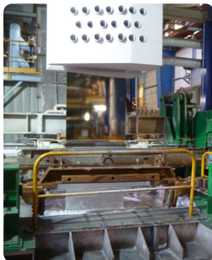
Nouvelle ligne de galvanisation zinc aluminium magnésium à Contrisson
