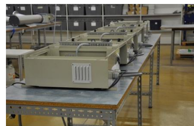
Câblage des boîtiers électriques UVC
