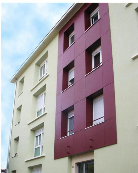
Afin d'améliorer la performance énergétique des logements sociaux et d'atteindre le label « BBC Rénovation », les 7 bâtiments, construits entre 1954 et 1969, ont bénéficié d'une rénovation complète de la façade ainsi que du remplacement des équipements thermiques, dont l'installation d'une chaudière collective à bois.
