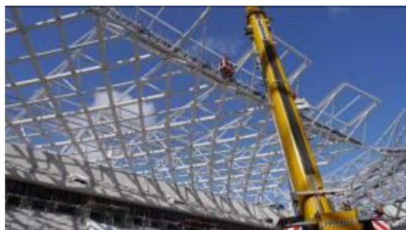
Montage des ossatures secondaires de l'avant bec - Crédit photo : Image de Com
