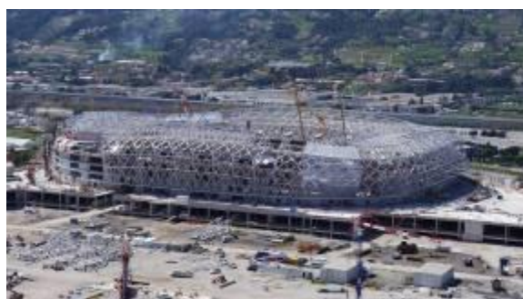
Le stade avant la mise en œuvre de l'enveloppe - Crédit photo : Image de Com
