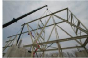
BCM (Baumet Constructions Métalliques), filiale de Soprema Entreprises, réalise la structure métallique en R+3, avec un important porte-à-faux de 14 mètres de long, sur l'ancienne toiture de l'entrepôt Seegmuller. L'entrepôt, situé sur la Presqu'île Malraux à Strasbourg, est transformé en programme immobilier, « les Dock's ».
