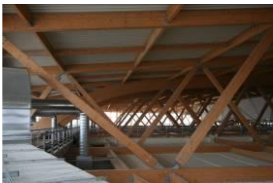
Sous-face de la toiture - Crédit photo : Soprema Entreprises
