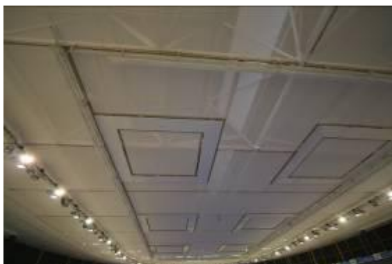
Toiture en transparence – vue intérieure du vélodrome - Crédit photo : Soprema Entreprises
