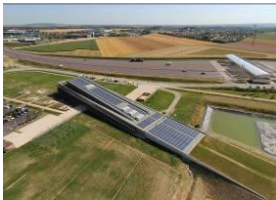
Ecopôle de la SANEF - Crédit photo : Frédéric Canon - Vertical Photo
