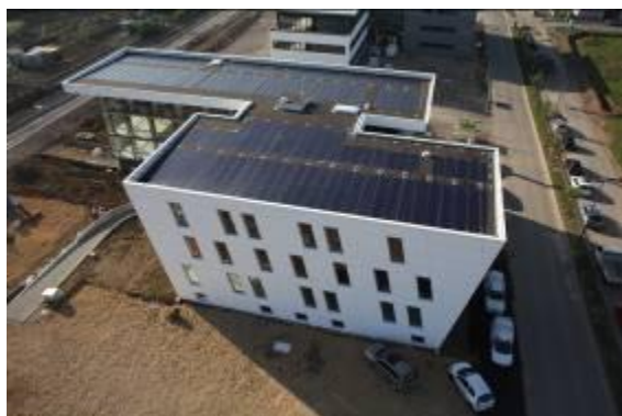
Busipolis à Metz - MOA : Sarl Busipolis - MOE : GHA Architectes - Crédit photo : Airshoot
