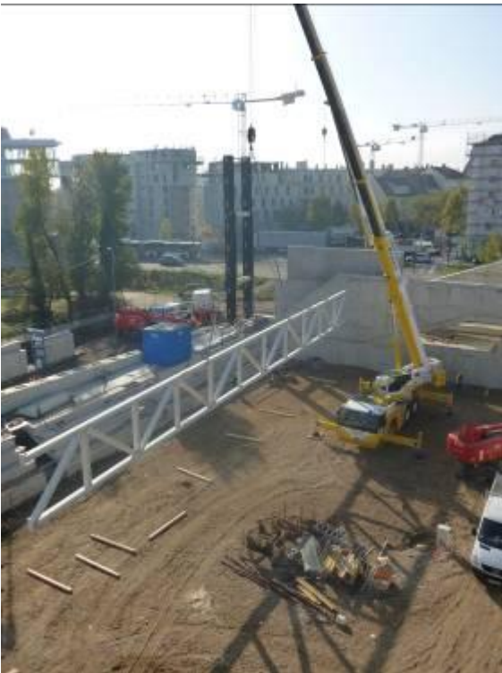
Levage de la première poutre de 9,5 tonnes à 12,5 mètres de hauteur - Crédit photo : BCM
