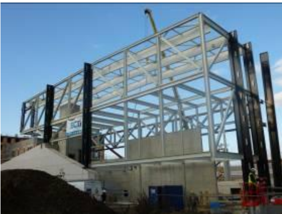
Montage du troisième portique métallique - Crédit photo : BCM
