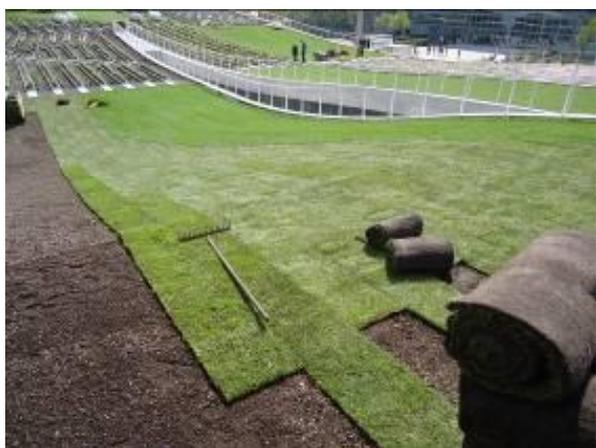
La partie Green se compose d'un assemblage de rouleaux précultivés de 1m<sup>2</sup> - Crédit photo : Soprema Entreprises
