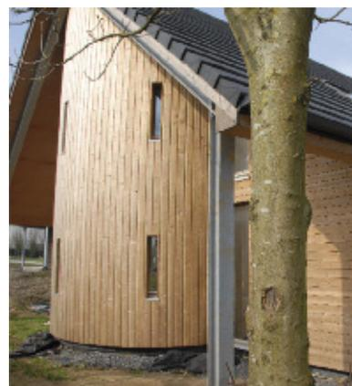
Pour les murs de ces maisons, les poutres en i FJI 45 x 300 mm sont positionnées à un entraxe de 600 mm et reliées par une lisse haute en Kerto-Q de 36 x 300 mm et une lisse basse en Kerto-Q de 27 x 300 mm, posée sur une sablière en Kerto-Q traité de 36 x 240 mm.
