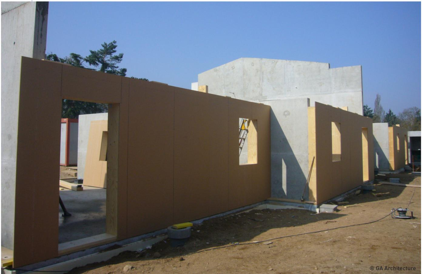
FIABITAT a préconisé pour les murs extérieurs une ossature bois en poutres en i FJI avec isolation 300 mm en ouate de cellulose avec un panneau de contreventement extérieur de 16 mm, une finition en bardage et une plaque de plâtre en face intérieure pour atteindre un  $U= 0.13 \text{ W}/(\text{m}^2\text{K})$ .
