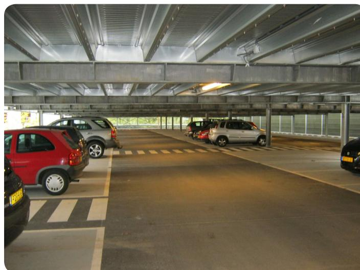
Première réalisation significative en Cofraplus 220, ce parking de 5 000 m<sup>2</sup> a fait l'objet d'un suivi très particulier de la part des ingénieurs d'ArcelorMittal Construction. Plusieurs innovations ont été mises à l'épreuve sur ce chantier-test qui a séduit les constructeurs flamands, jusque-là habitués aux structures en béton.
