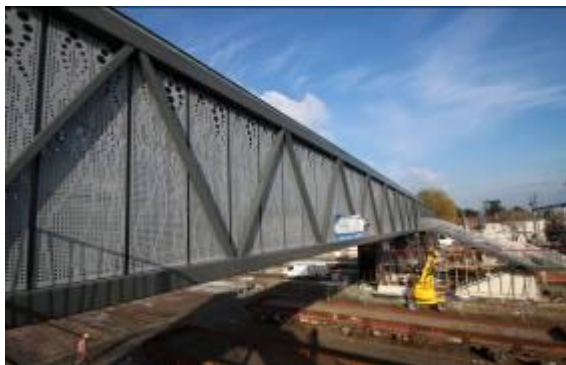
La nouvelle passerelle - Crédit photo : GH
