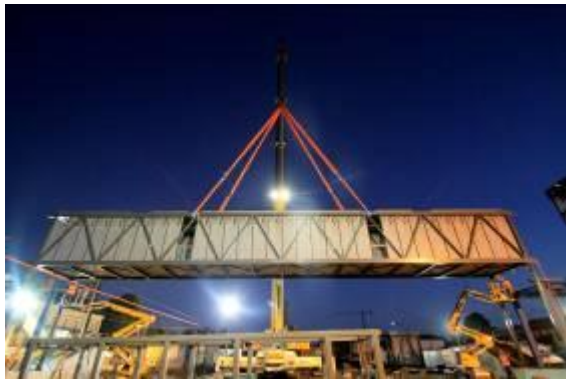
Levage de nuit de la nouvelle passerelle - Crédit photo : GH
