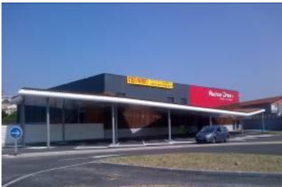
Auchan Drive à Caluire - MOE : Iliade Ingénierie - Crédit photo : BCM
