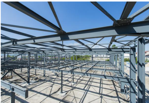
Détails de la charpente - Bureaux et ateliers de la Fondation Richard - MOE : em2c construction - Crédit photo : Julien Rambaud
