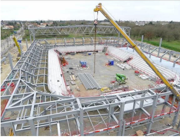
Pose des gradins et des supports de planchers - Crédit photo : SMB
