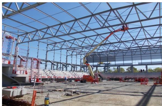
Démarrage du bardage - Crédit photo : SMB
