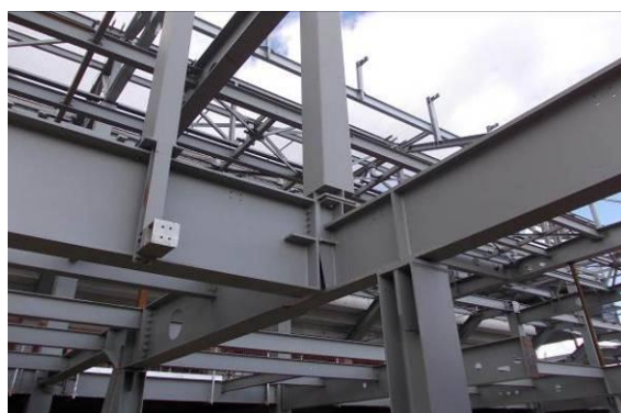
Détail des assemblages - Crédit photo : SMB
