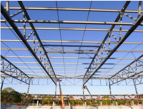
Charpente apparente de la salle principale – Crédit photo : SMB
