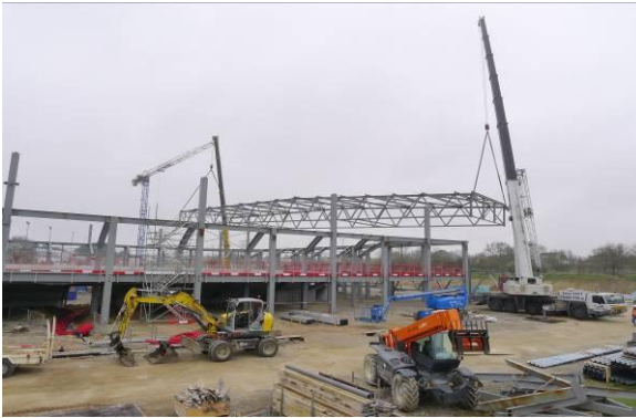
Levage du carré sud - Crédit photo : SMB
