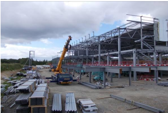
Pose des porte-à-faux des annexes - Crédit photo : SMB
