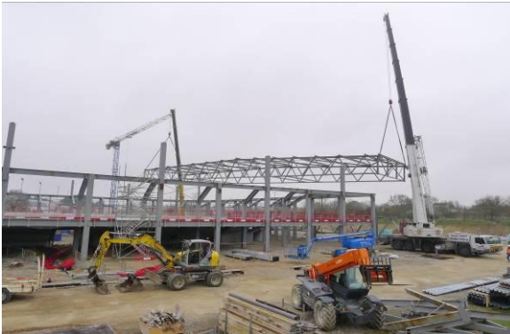
Levage du carré sud - Crédit photo : SMB
