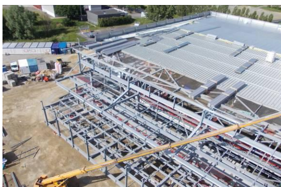
Vue aérienne d'ensemble - Crédit photo : SMB
