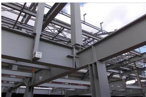
Détail des assemblages - Crédit photo : SMB
