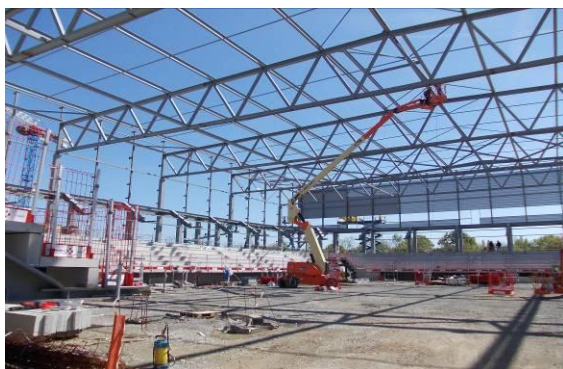
Démarrage du bardage - Crédit photo : SMB
