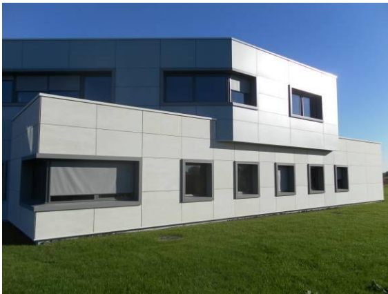
SCI AURA à Cébazat (63) - MOE : Bernard Jeanjean Architecte Crédit photo : Soprema Entreprises
