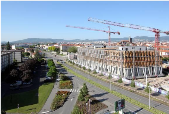
Chantier en cours - Crédit photo : s.quattrocchi@balloide-photo.com
