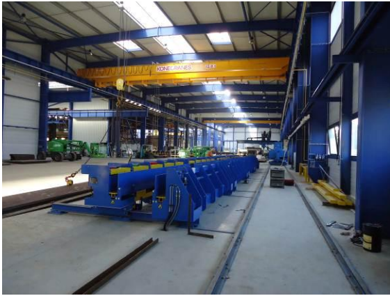
Banc d'assemblage - Crédit photo : SMB
