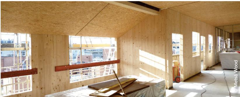
Grâce à ses grandes portées, l'utilisation du Kerto-Ripa® de mur à mur porteur offre également un large volume intérieur puisqu'il ne nécessite pas d'appuis intermédiaires.
