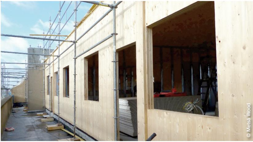
Pour sa conception, l'agence d'architecture Lair & Roynette a souhaité créer une rupture harmonieuse avec la bâtisse existante en béton. Pour ce faire, elle a fait le choix de mixer 2 systèmes constructifs en bois préfabriqués en murs et toitures. Ce sont les solutions de panneaux massifs Leno® et caissons structuraux Kerto-Ripa® de Metsä Wood qui ont été finalement retenues.
