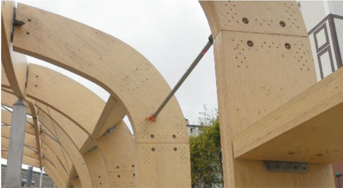
Ainsi, ce souci du détail déjà suggéré dans les carnets de détail de l'appel d'offre (BET VS-A) puis confirmé en phase EXE (Poulingue et Charpente Concept), a permis de créer au final une **charpente d'allure très légère et homogène avec des assemblages brochés discrets.**
