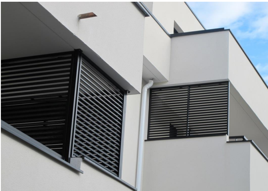
Crédit photo : ICF Habitat
