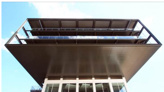
Dock's de Strasbourg - MOE : Georges Heintz-Kehr et PH Architecture
