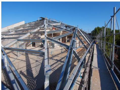
Charpente métallique destinée à accueillir la toiture en bacs acier
