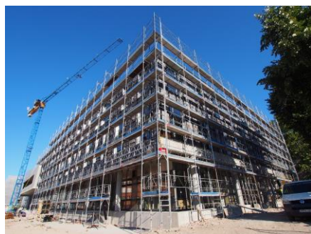
Echafaudage périphérique dépassant la toiture de 2.50 m
