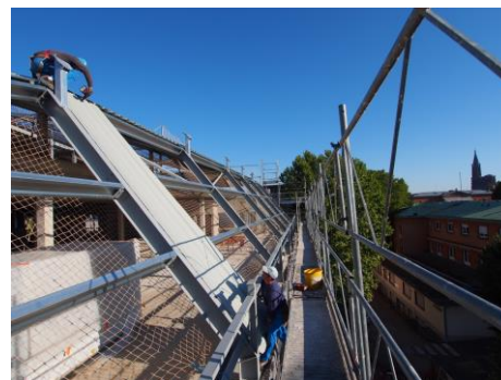
Pose des bacs acier sur la charpente métallique à forte pente
