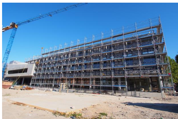
Pose du bardage en cours
