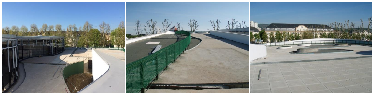
Pose de la chape par les équipes de Soprema Entreprises avant la mise en œuvre de la végétalisation - crédit photos : Soprema Entreprises
