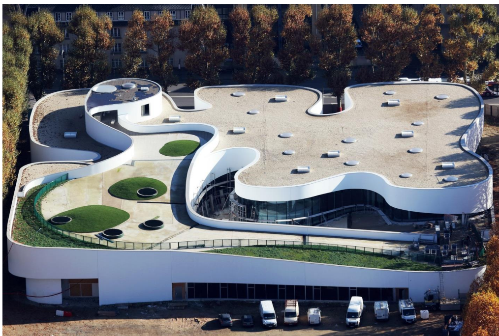
Vue aérienne de la toiture en phase d'achèvement - Crédit photo : Les Quatre Vents
