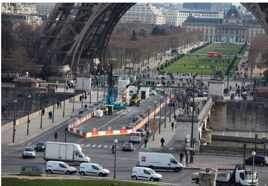
Le Pont d'Iéna, d'une longueur de 155 m, se présente sous la forme de trois ouvrages parallèles, lesquels regroupent 5 arches de 28 m de portée respective. L'ouvrage central est un pont en maçonnerie, tandis que les deux ouvrages latéraux constituent des élargissements en béton armé habillés d'un parement extérieur en pierre, construits vers 1937.
