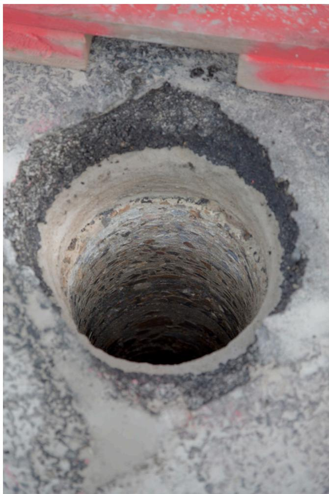
Chaque micropieu est donc équipé d'un tube d'armature tubulaire de 140 mm de diamètre et de 20 mm d'épaisseur. Les tubes sont dotés de renforts d'adhérence sur toute la hauteur de la maçonnerie et de pastilles au droit du terrain destinées à la réalisation des injections.
