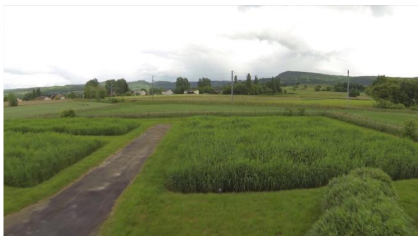
La station d'épuration de Vercia, STEP à filtres plantés de roseaux
