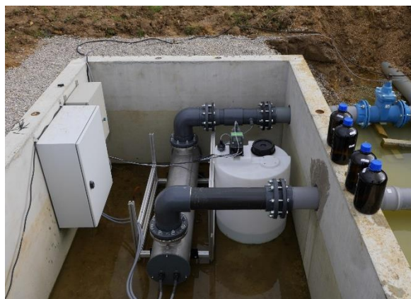
Prototype UV / H 2 O 2 installé sur la STEP de Vercia
