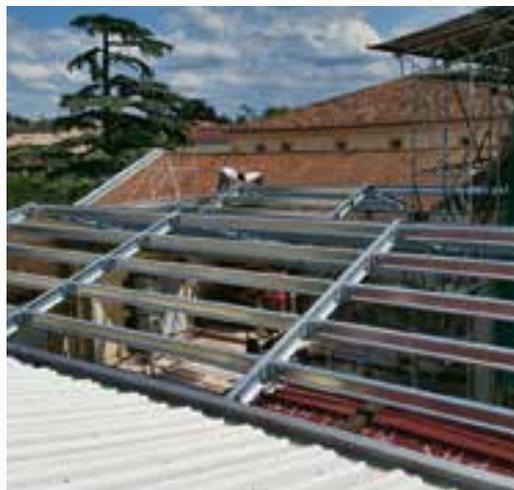
2. Pose des poutres et multibeam®
