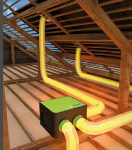
Moteur et gaines de distribution dans les combles
