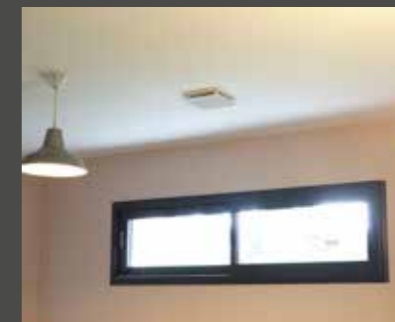
Bouche de soufflage dans la cuisine
