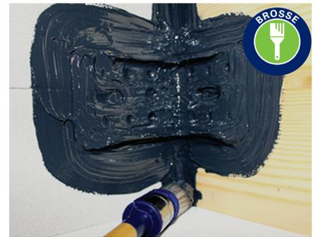
**MB925** est une membrane saine (0% solvant, isocyanate, silicone), de technologie hybride, à faible viscosité, chimiquement neutre, non corrosive et à faible odeur. Après polymérisation, elle forme un revêtement à élasticité durable, résistant aux UV et aux intempéries.
