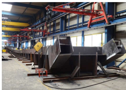
Fabrication du tablier dans les ateliers de SMB
