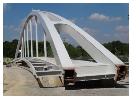
Assemblage du tablier et de l'arc sur place
