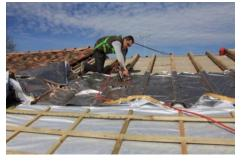
Simple et agréable à mettre en œuvre, la solution TRISO-SUPER 12 BOOST'R<sup>S</sup> se pose par agrafage et se découpe facilement au cutter.
