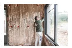
Il se met en œuvre sans modifier les habitudes des professionnels : il se découpe facilement au couteau ou à la scie électrique. A la fois rigide et résilient, il peut se comprimer aisément dans les deux sens avec une bonne tenue mécanique permettant une finition parfaite.
