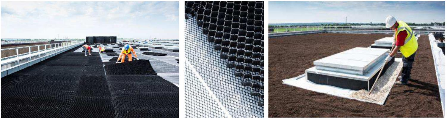
*Pose du système Retentio® (à gauche et au centre) et traitement des zones stériles (à droite) par Soprema Entreprises
