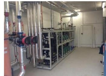
MCI réalise également un **quai réfrigéré à +2/+4°C** pour importer et exporter les produits dans les locaux de DISGROUPE. La prestation comprend également la création d'une **chambre de stockage de poudre de maïs avec température et hygrométrie contrôlée** (12°C et taux d'humidité de 70%) raccordée sur l'installation déjà existante.
