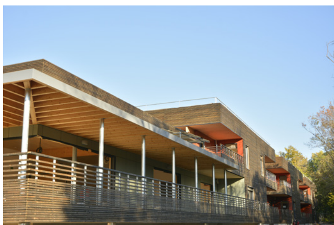
Foyer de Vie pour l'Association Régionale pour l'Intégration à Marseille
