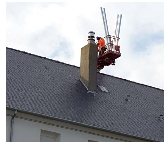
Le reste de l'équipe assure ensuite la connexion au cône de condensats situé au RDC et réceptionne chaque élément d'étage pour fixer l'ensemble.
