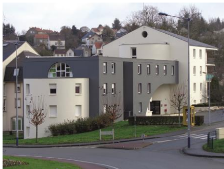
Logements (Guéret), Solution Sto : système d'imperméabilité I1 en Irtop S, velouté mat X-black, Maître d'ouvrage : Creusalis
