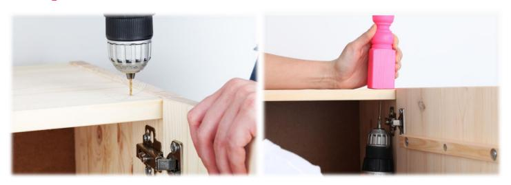
Fixer les pieds de l'armoire à l'aide de la perceuse et du tournevis, et la bordure grâce à la colle à bois.
