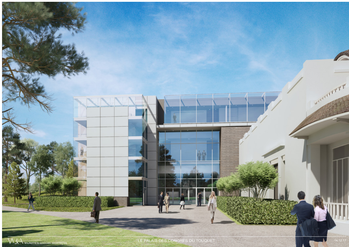
Vue sur le nouveau bâtiment depuis le parvis ©Wilmotte & Associés Architectes
