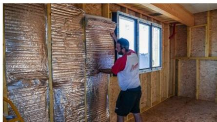
« Le confort de pose des produits ACTIS est impressionnant : ils sont légers à manipuler, à mains nues, ne dégagent aucun composant désagréable à toucher ou inhaler, sont simples à découper avec un simple cutter ou une scie...et laissent le chantier sans poussière, facile à nettoyer », souligne Anthony Lallemand.
