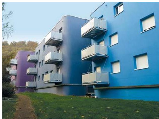
Cité du Wiesberg à Forbach, réhabilitation en ITE d'un ensemble classé au patrimoine du XXe siècle. Solutions Sto : Système d'ITE hydraulique StoTherm Vario, avec isolant polystyrène cintré, enduit de finition siloxané StoSilco K, et peinture en teintes soutenues StoColor X-black. Architecte : Atelier Choiseul - Architecture originale d'Emile Aillaud, mise en couleur par l'artiste Fabio Rieti. Bailleur : SNI Ste-Barbe.
