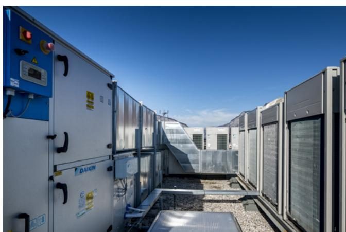
En termes de confort, Avenel Promotion et le BET Aria Fluides ont été conquis par le chauffage continu en cycle de dégivrage et la température de soufflage au niveau des unités intérieures grâce à la variation de température du fluide en mode chaud froid, valorisable dans le calcul de la RT 2012.
