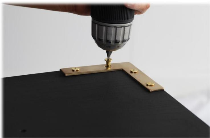
Placer les équerres d'assemblage sur les coins des tiroirs et pré-percez de petits trous de sorte à ce que les vis puissent se visser facilement.
