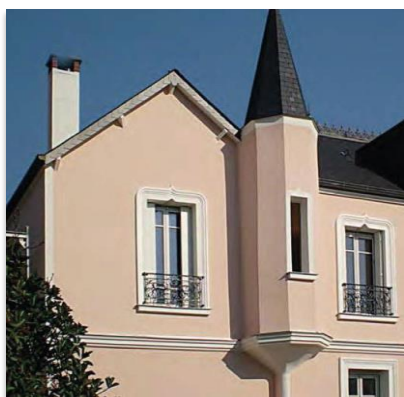
Pavillon de style atypique, La Varenne-St-Hilaire (94) : rénovation d'une ITE dégradée avec mise en place de modénatures StoDéco Profil réalisées sur mesure.
