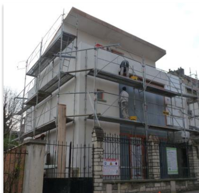
Rénovation en ITE d'une maison individuelle à Suresnes (92).
