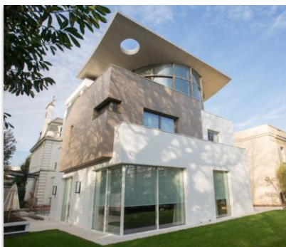
Pavillon neuf à Boulogne Billancourt (92.) Système StoTherm Classic finition Stolit Milano aspect marmorino métallisé.
