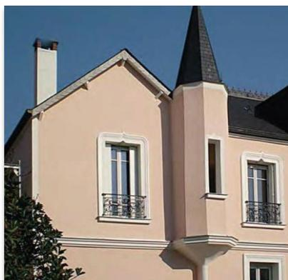
**Pavillon de style atypique, La Varenne-St-Hilaire (94)** : rénovation d'une ITE dégradée avec mise en place de modénatures StoDéco Profil réalisées sur mesure.
